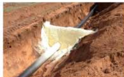
Пенополиуретан для заполнения канав
