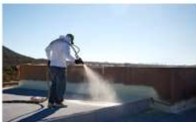
Распыление пенополиуретана для кровельных работ
